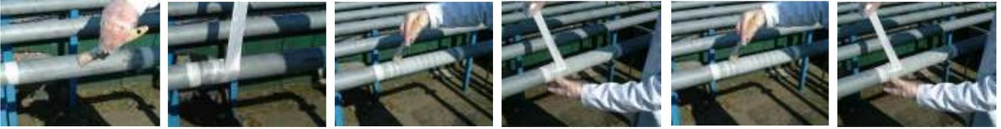
使用301管道增强涂层及50mm宽的玻璃钢增强带，用于管道的在线堵漏&增强施工。
