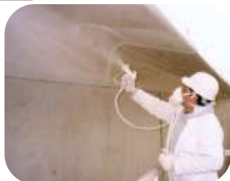
混凝土墙面使用2层556透明防水涂层密封。
