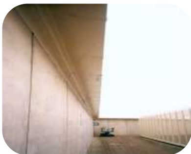
混凝土墙面使用2层556透明防水涂层密封。
