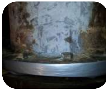
泄露管道的低温粘接
