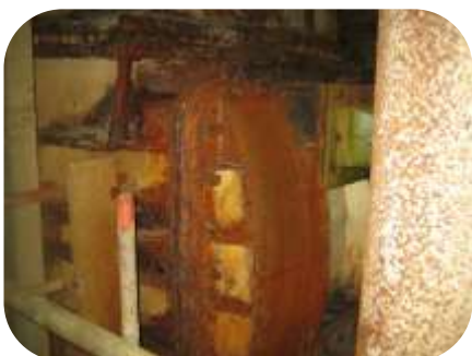
对泄露的冷却箱法兰的紧急密封
